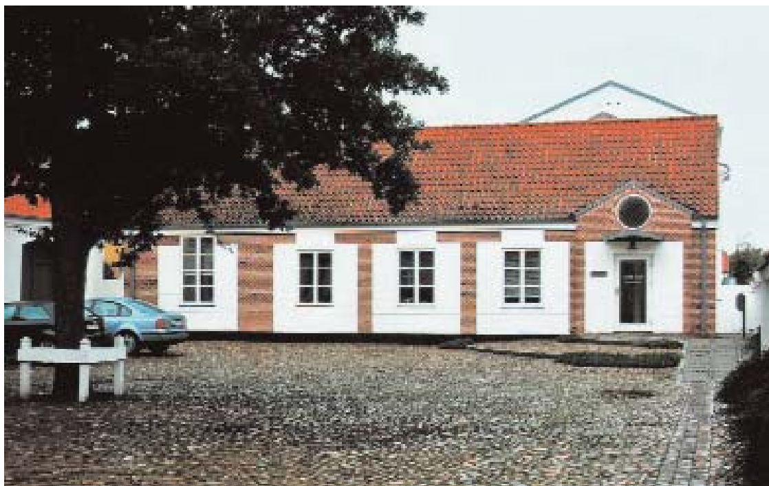
Fig. 8. Ribe Bispegård, tilbygning.
