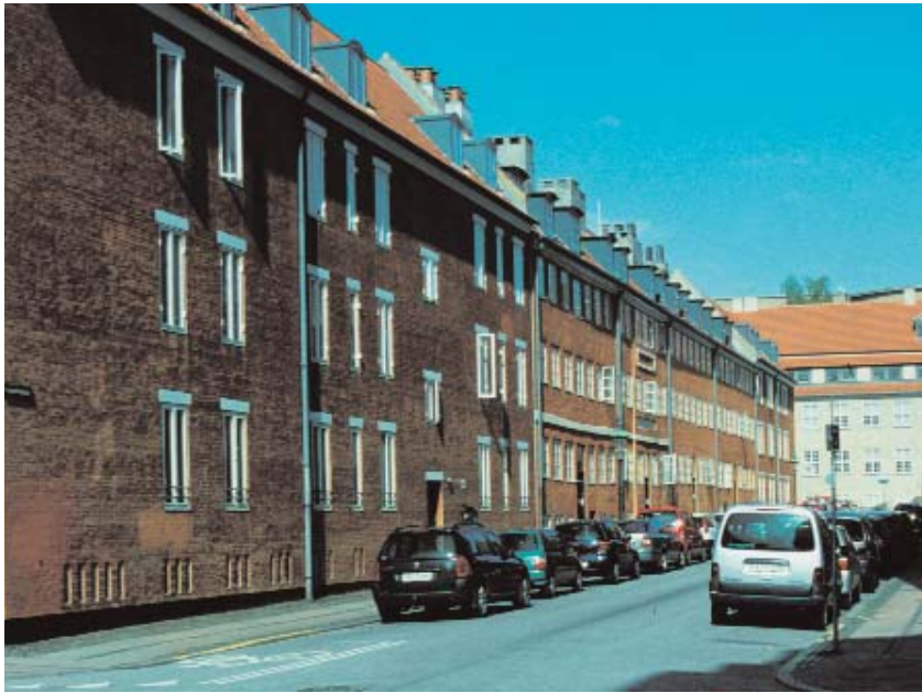
Fig. 19. T.v. Fredericiagade i København med tilføjelser til begge ender af den gamle husrække.
