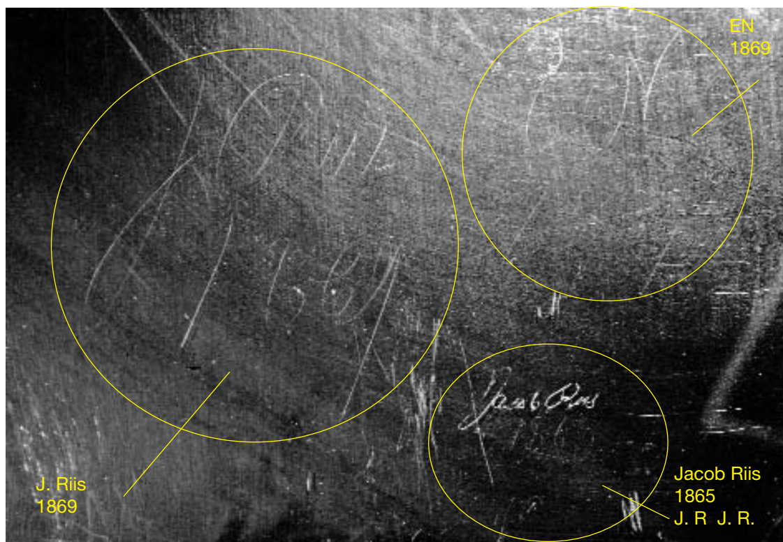
Fig. 11. Fragmenteret vinduesrude fra gårdsiden af Sortebrødregade 3 (ASR 21M80E, nr. E5359). Foto: SJM.
